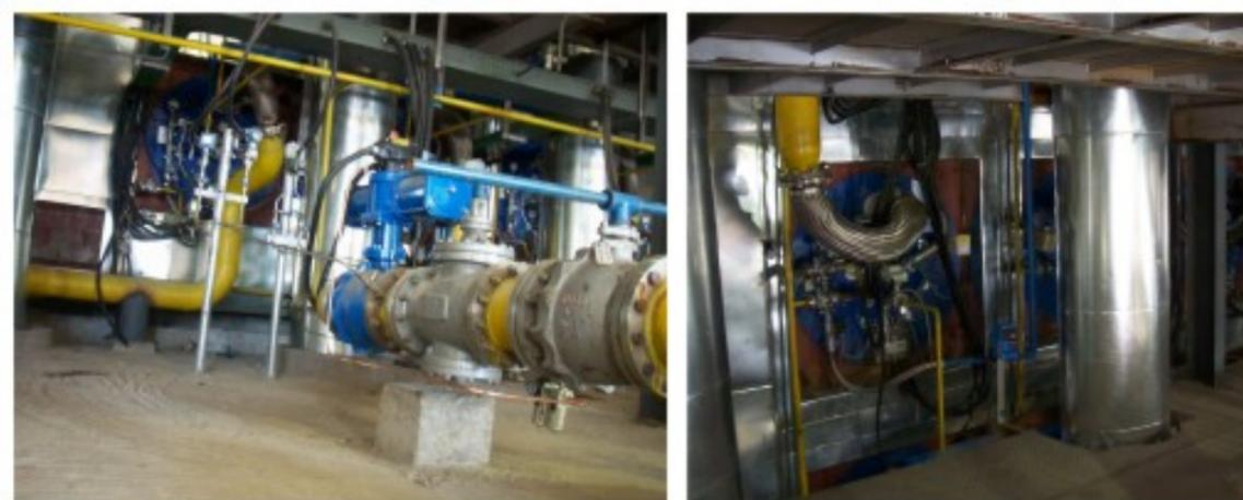
18台 JBD-32000-G燃烧器在中国吉林发电厂2台220T水管锅炉上使用。
